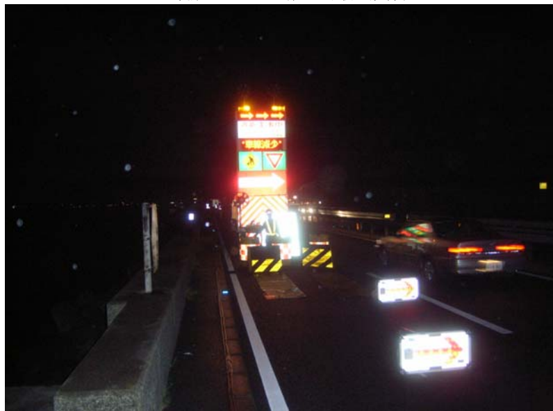
規制設置状況
