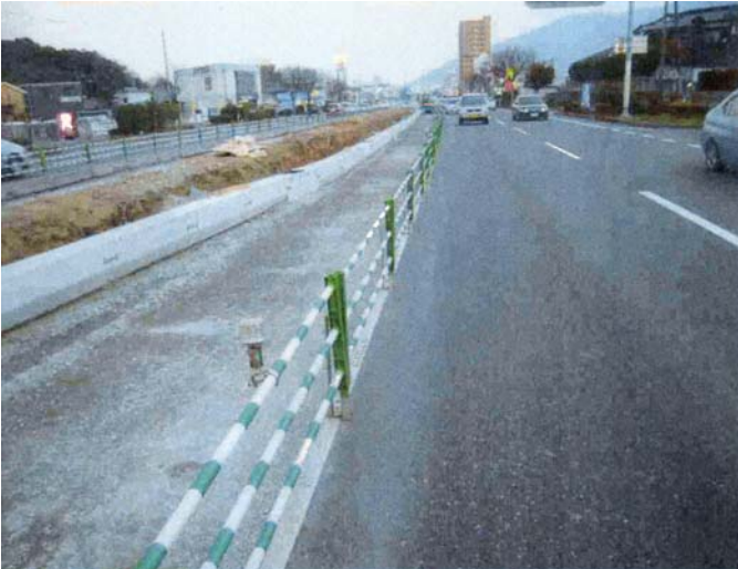
SSバリケード設置状況(上り線側)
