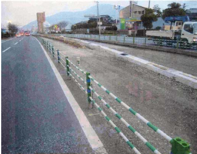
SSバリケード設置状況(下り線側)
