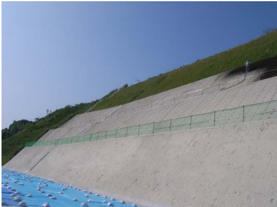
法面作業状況
