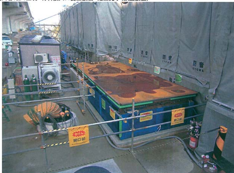
写真内容:第4立坑 材料投入口養生設備 是正完了(鉄蓋設置)
