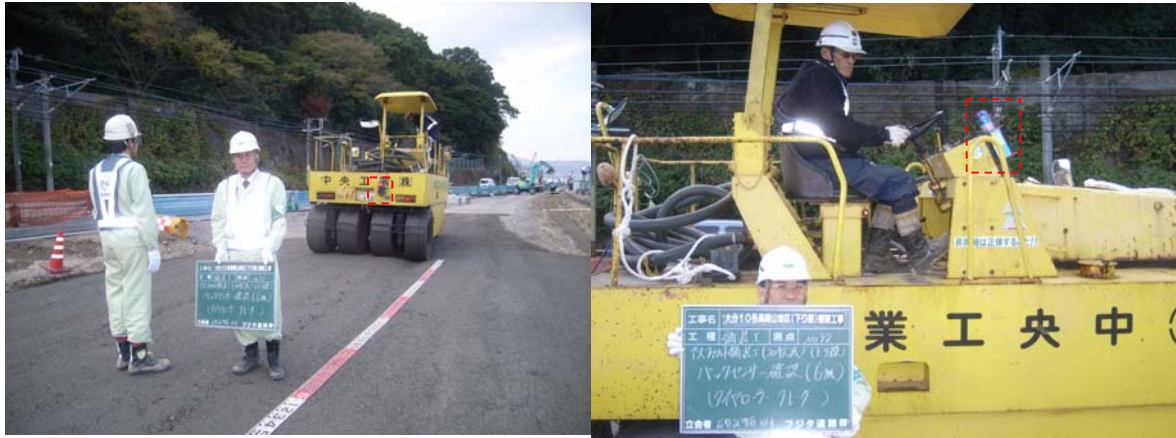
タイヤローラーバックセンサー搭載状況
