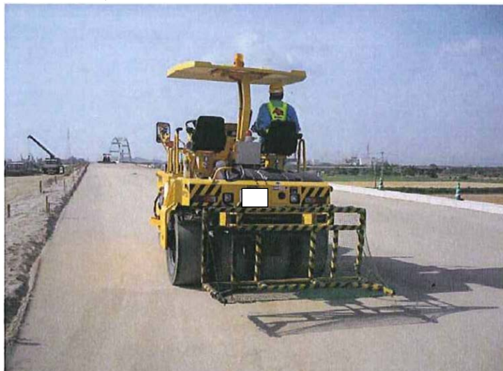
巻き込み装置の取り付け状況
