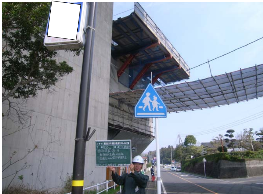
作業床・外周メッシュシートの先行設置
