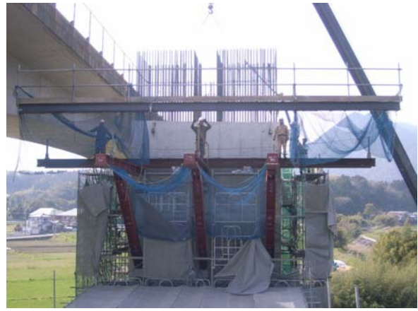
ラッセルネット・巾木の先行設置
