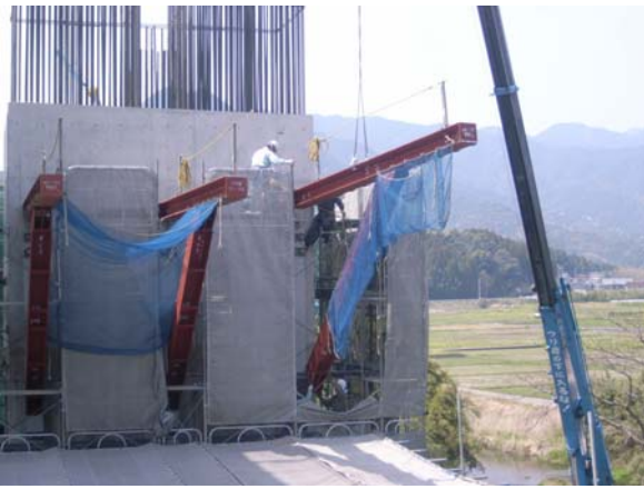
ラッセルネットの先行設置
