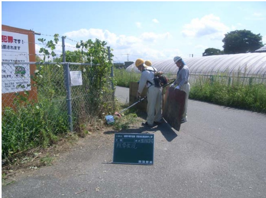
新防護カバーの除草状況
