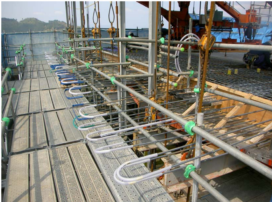
鉄筋先端部の保護状況
