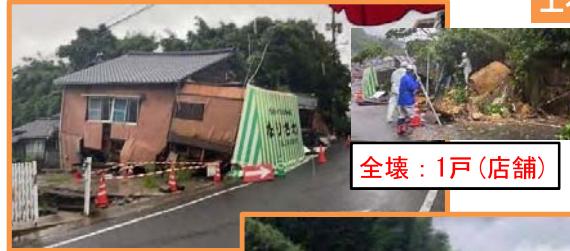
がけ崩れ 長崎県佐世保市大黒町
