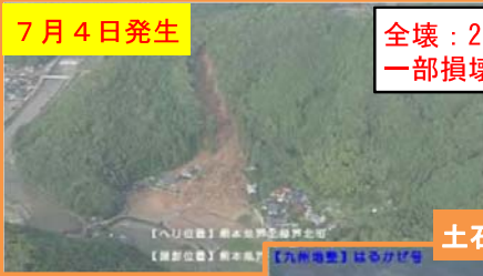
がけ崩れ 熊本県葦北郡芦北町田川
