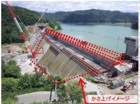
ダム建設・ダム再生
