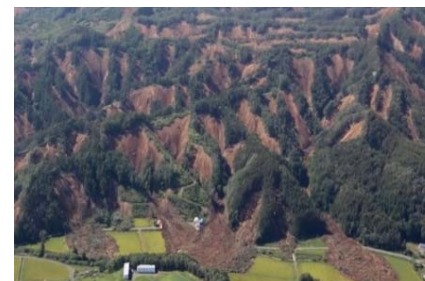
⑦土砂災害の状況 (北海道勇払郡厚真町)
