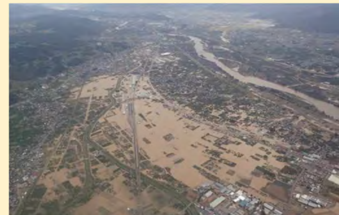
千曲川における浸水被害状況
