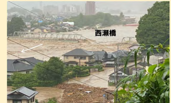
球磨川における西瀬橋の流出
