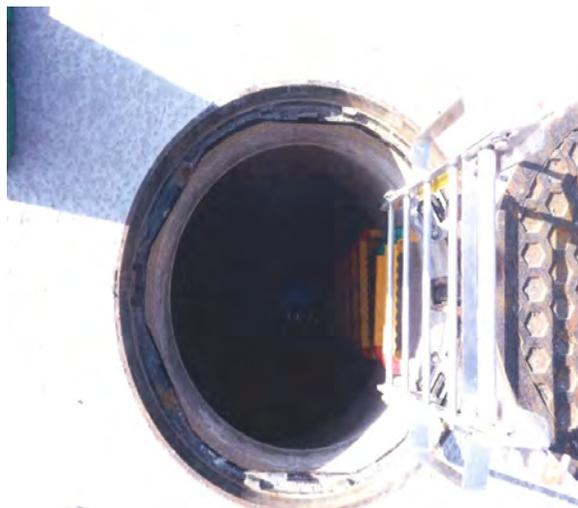
▲ 1,000㎡に1箇所程度、新設道路内に雨水浸透柵の設置
