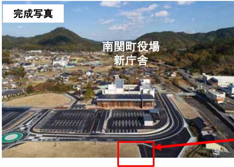
地下埋設型調整池設置完了(令和4年1月)
