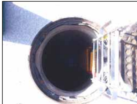
1,000㎡以上の開発行為に対する新設道路内、雨水浸透柵の設置例
