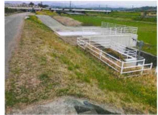
ポンプ設置場所の整備完了
