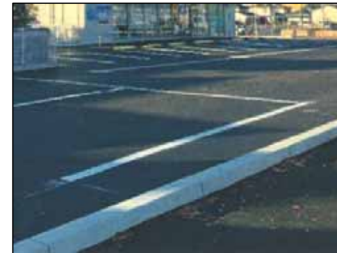
駐車場内の透水性舗装施工例
