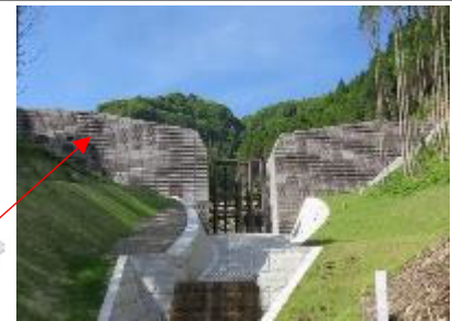
砂防堰堤 平水時は土砂を安全に下流へ流下させ、洪水時は異常な土砂流出を抑制します。
