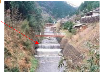
溪流保全工 氾濫を防止し河床の固定と河岸の保護を目的に整備します。
