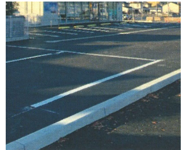
▲ 駐車場内の透水性舗装
