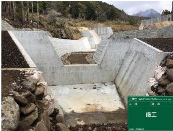
湯舟川 溪流保全工整備状況
