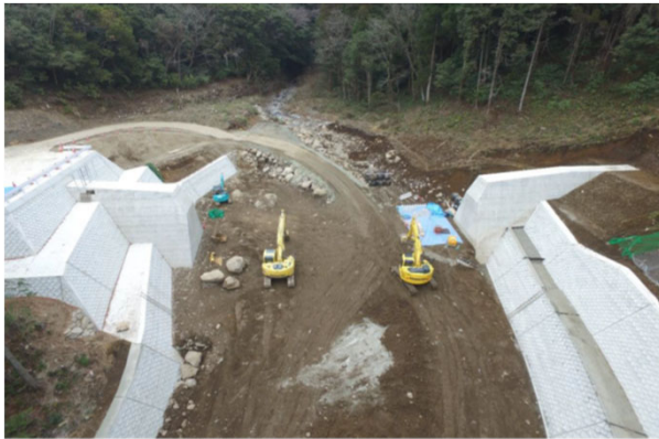
狐塚川 砂防堰堤整備状況
