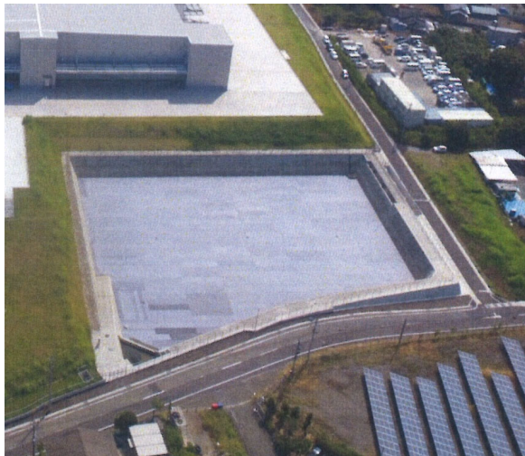
▲ 雨水調整池の設置
