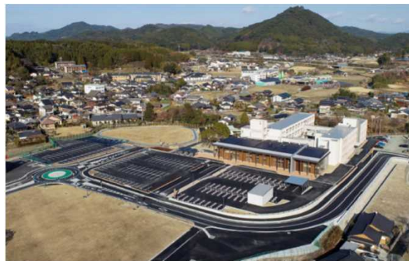
南関町役場及び防災広場(南関町)
