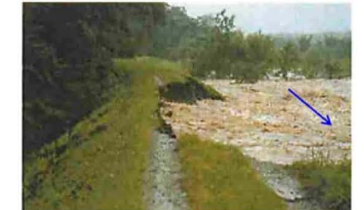
侵食の拡大による堤防決壊の恐れ
