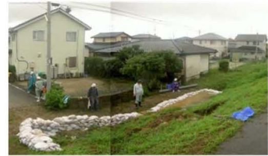
漏水の進行による堤防決壊の恐れ
