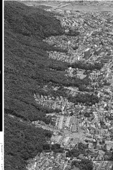
山道を開き、土砂災害が起きた広島市安佐南区の住宅地。山道を切り開いて開発が進んだ＝21日午後0時13分
