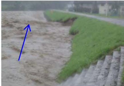
異常な侵食の発生
