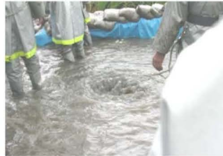
異常な漏水の発生
