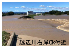
越辺川右岸0k付近
