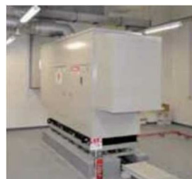
非常用発電設備のイメージ
