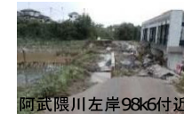
阿武隈川左岸98k6付近
