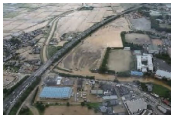
桂川における浸水被害(福岡県 朝倉市)
