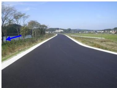
堤防天端をアスファルト舗装、法尻の保護
