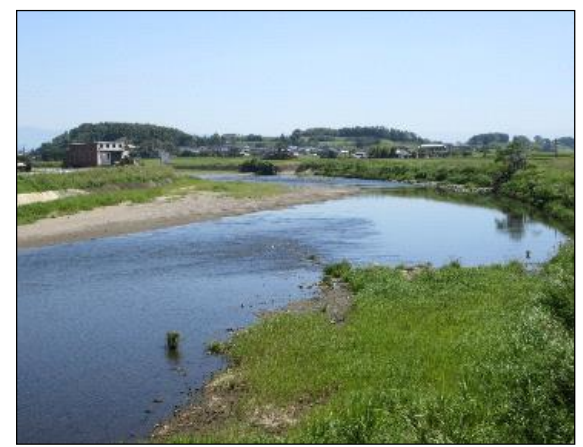
河道掘削箇所の状況
