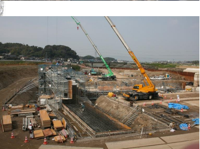
平島堰の改築工事状況
