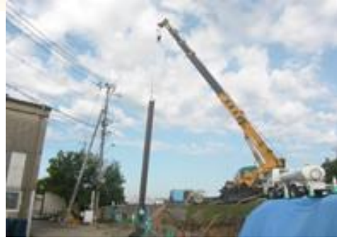
滑石地区における沈下対策
