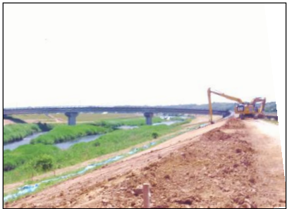
堤防法面の補修
