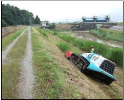
堤防法面の除草
