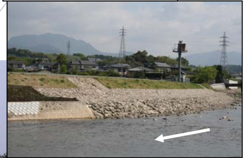
自然石による護岸工
