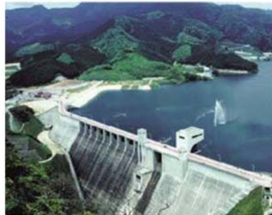
竜門ダムの洪水調節状況（H21年6月29日～30日 梅雨前線） ～最大流入時のダム通過量を約50%低減し、下流の水位を約0.3m低減～
