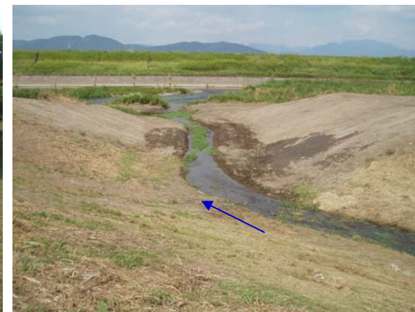
せせらぎ水路(末広排水樋管)
