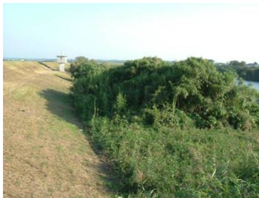
樹木の繁茂状況 （菊池川37k付近）
