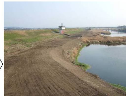
樹木伐開後の様子 （菊池川37k付近）
