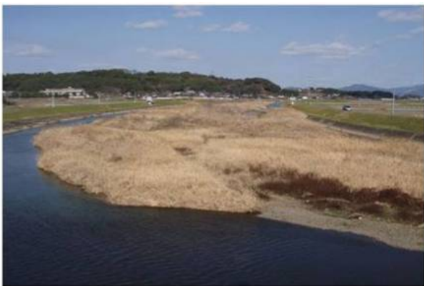
河道内に堆積した土砂（合志川）
