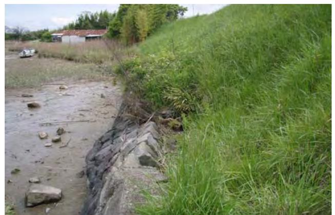
写真 2.1.8 堤防護岸の損傷
