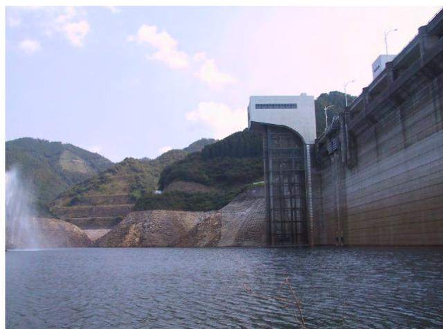
写真 4.3.7 竜門ダム選択取水設備
