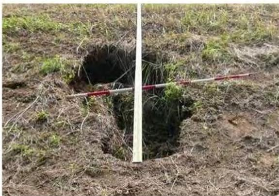
写真 2.1.7 堤防斜面の陥没
