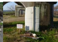
菊池川左岸 10k680 仮設トイレ
