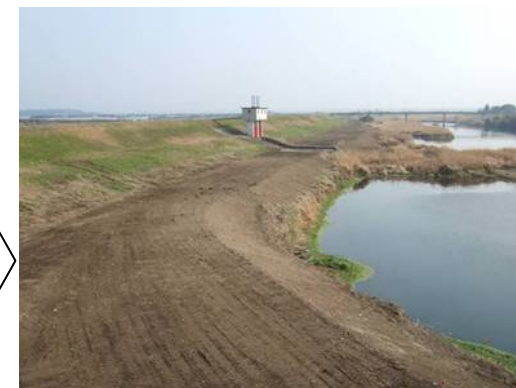
樹木伐開後の様子 （菊池川37k付近）
