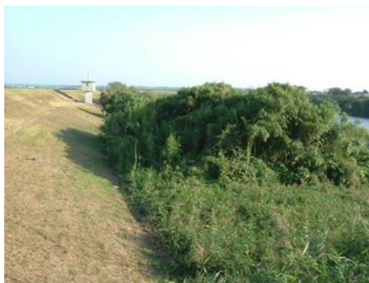
樹木の繁茂状況 （菊池川37k付近）
