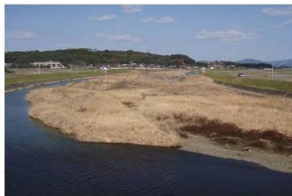
河道内に堆積した土砂（合志川）
