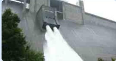
洪水調節用のコンジットゲートより放流
