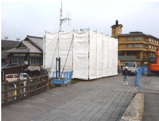
山鹿水位観測所の工事の様子
