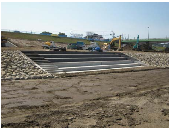
親水階段の工事の様子
