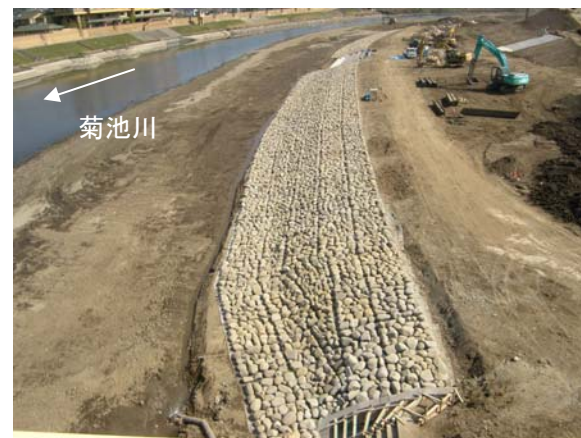
環境護岸の工事の様子
