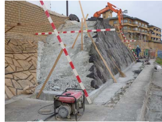
階段護岸の工事の様子
