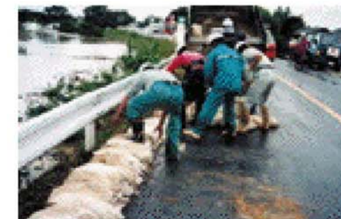
水防団による土のうづみ
