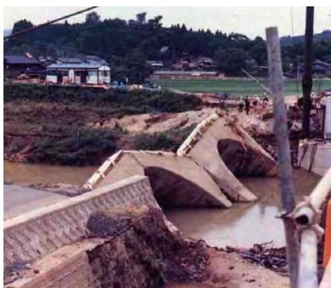
写真 1.2.5 支川和仁川0.6km付近平野橋の流失状況（和水町）
