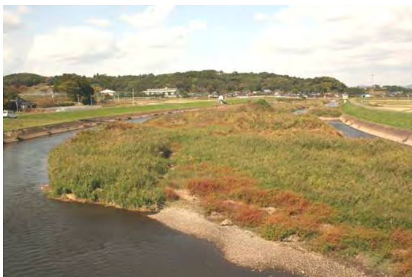
写真 2.1.1 合志川の土砂堆積状況
