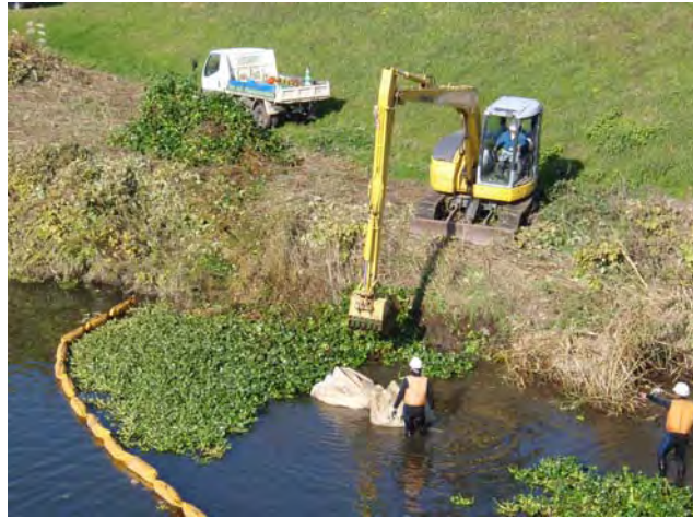
写真 2.2.13 水草撤去状況
