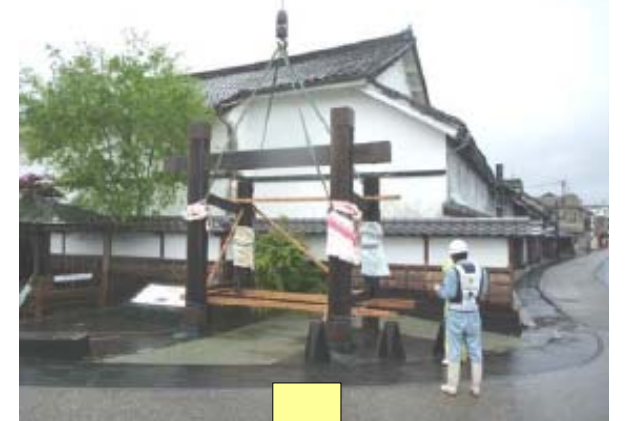
右岸状況(惣門の移設)
