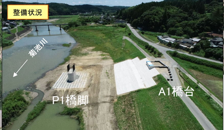
菰田橋架替(整備中)
