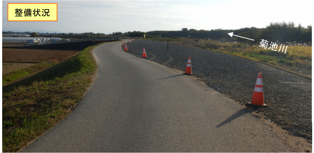
小島地区:築堤(整備中)
