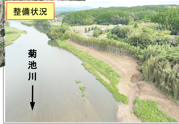
菊池川21k0付近: 樹木伐開(整備後)
