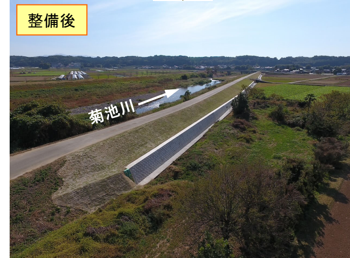
深川地区の堤防浸透対策
