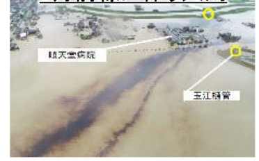
⑧六角川周辺における浸水被害状況 (佐賀県大町町)
