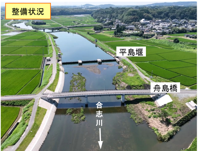
平島堰改築・舟島橋架替(整備後)
