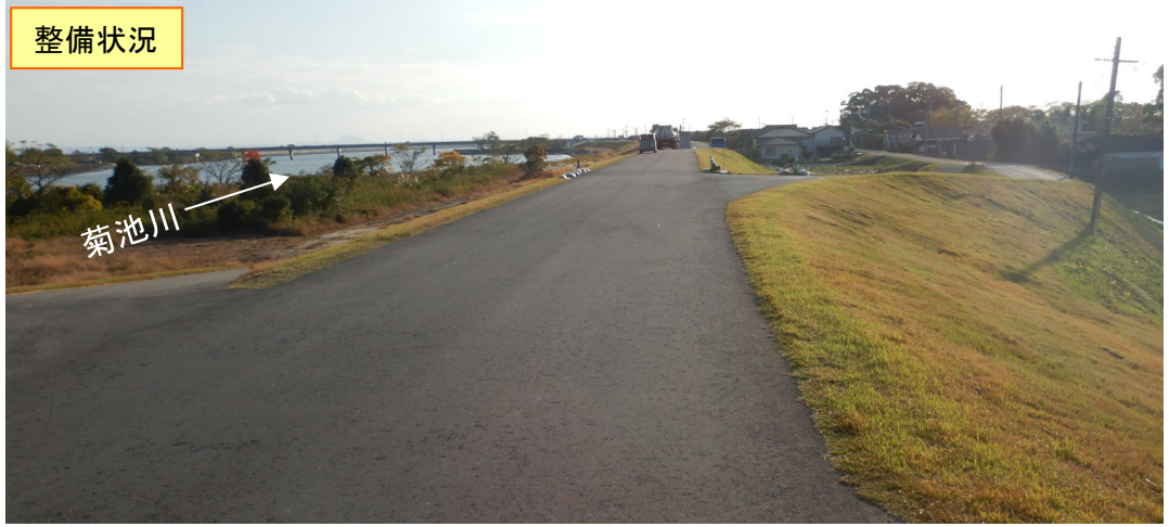
小浜地区: 築堤(整備後)
