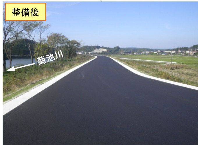
大江田地区の堤防天端舗装・法肩補強
