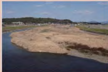
河道内に堆積した土砂（合志川）
