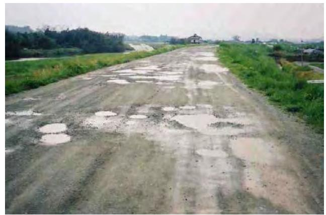
写真 2.1.10 堤防上面損傷による水たまり
