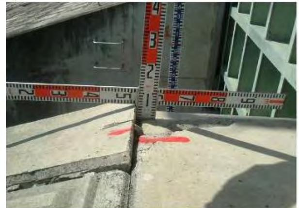
写真 2.1.12 樋門・樋管のひび割れ状況
