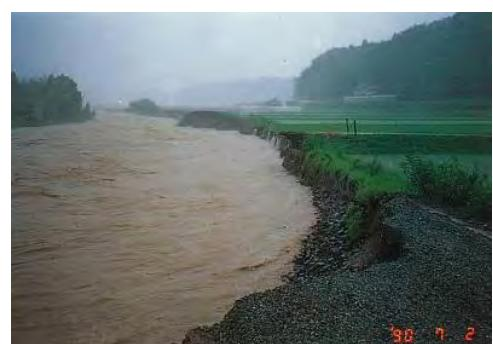
写真 2.1.4 堤防被災状況 (H2.7 上内田川 菊池市)
