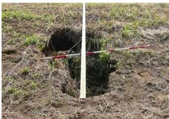
写真 2.1.7 堤防斜面の陥没
