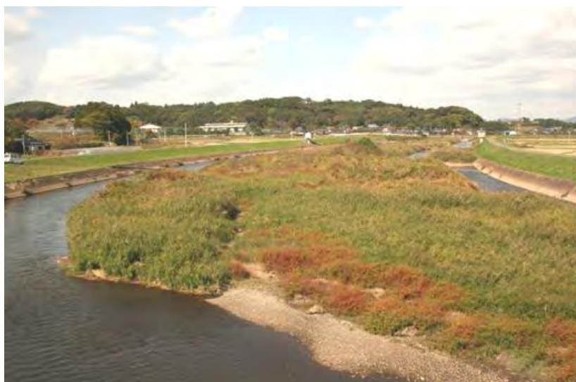
写真 2.1.1 合志川の土砂堆積状況
