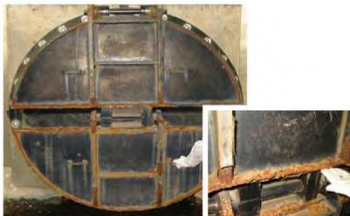
写真 2.1.11 排水ポンプ場内の施設腐食状況
