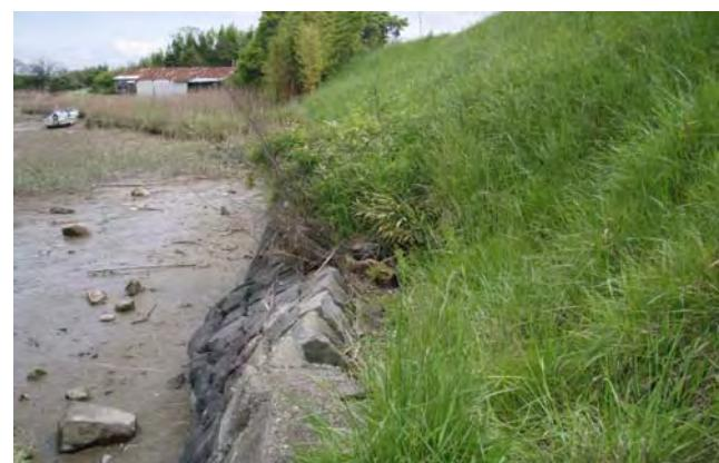
写真 2.1.8 堤防護岸の損傷
