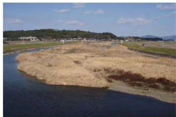
写真 2.1.6 河道内に堆積した土砂（合志川）
