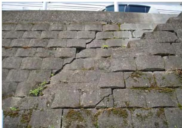
写真 2.1.9 堤防護岸のひび割れ
