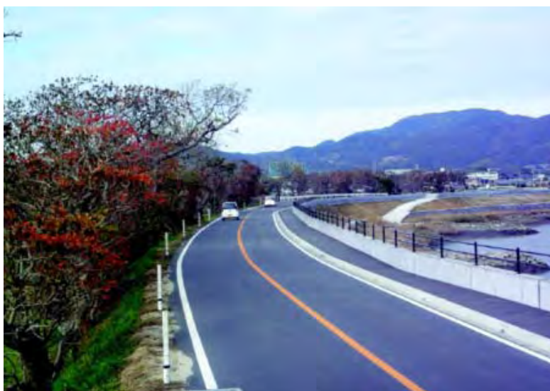
写真 4.2.6 ハゼ並木に影響しないように施工した堤防整備（特殊堤防）（玉名市小浜地区）
