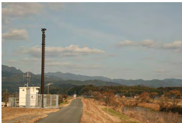
写真 4.3.16 現地設備（監視カメラ及び水位観測所）
