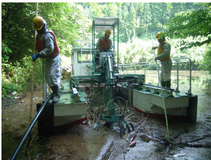
写真 2.1.15 貯水池流木等除去状況
