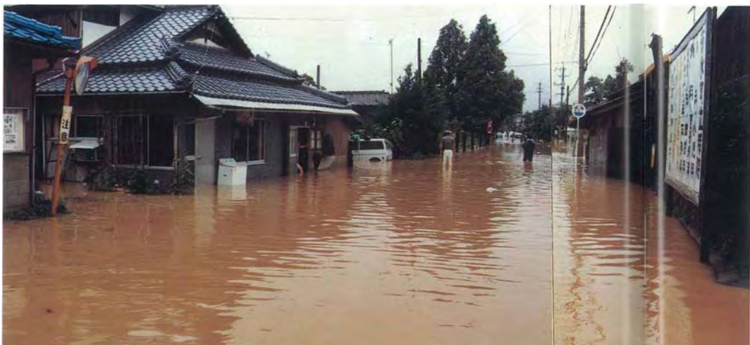
写真 1.2.8 支川合志川 6.5km 付近浸水状況（熊本市）
