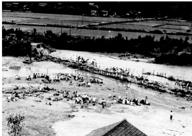
写真 1.2.4 支川繁根木川はん濫による県道の決壊状況 (玉名市)
