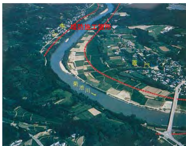
写真 1.2.16 激特事業での築堤
