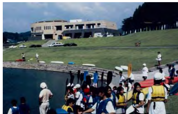
写真 2.2.15 菊水ロマン館（カヌー館） 菊水ロマン館はレストラン、物産館、温泉が一つになった複合施設（道の駅）です。周辺には、江田船山古墳・肥後民家村・カヌー館等があり、多くの人々で賑わいます。
