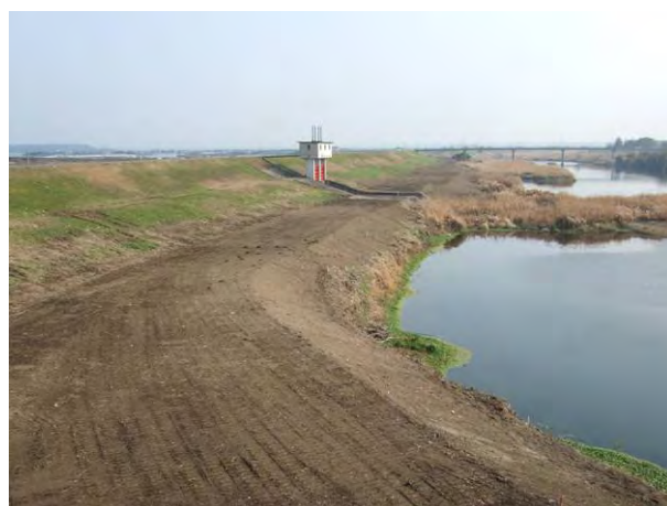
写真 4.3.2 樹木伐開後の様子 (菊池川 37k 付近)
