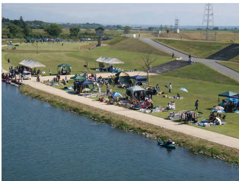
写真 4.2.7 地域と連携し施工した河川整備（山鹿市）
