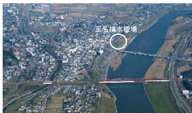
写真 1.2.15 玉名排水機場と背後地
