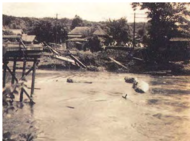
写真 1.2.2 本川 47km 付近熊本電鉄 (橋梁) 流出状況 (菊池市)
