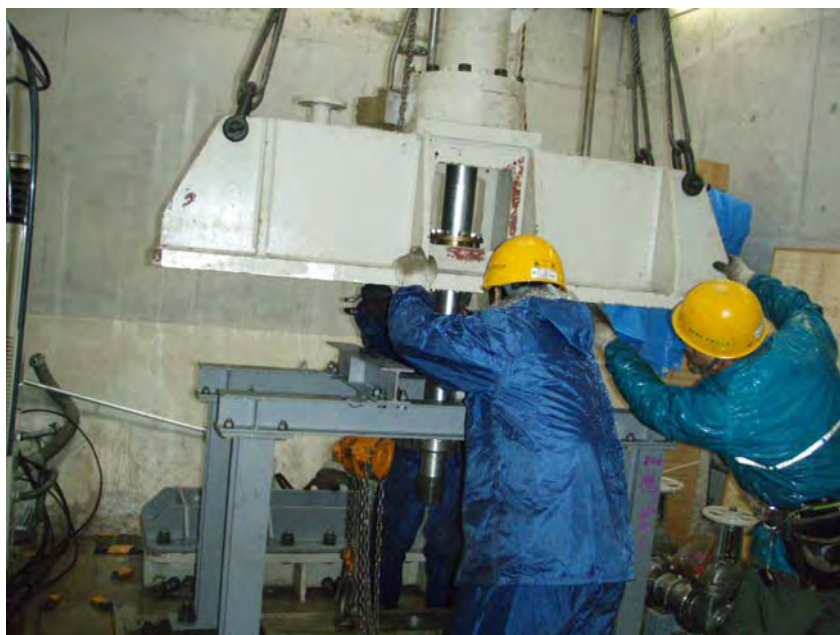
写真 2.1.14 放流設備補修状況
