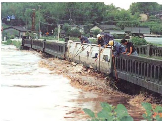
写真 1.2.11 支川合志川 4.5km 付近の伊知坊橋 の水防活動（流下物除去）状況（熊本市）
