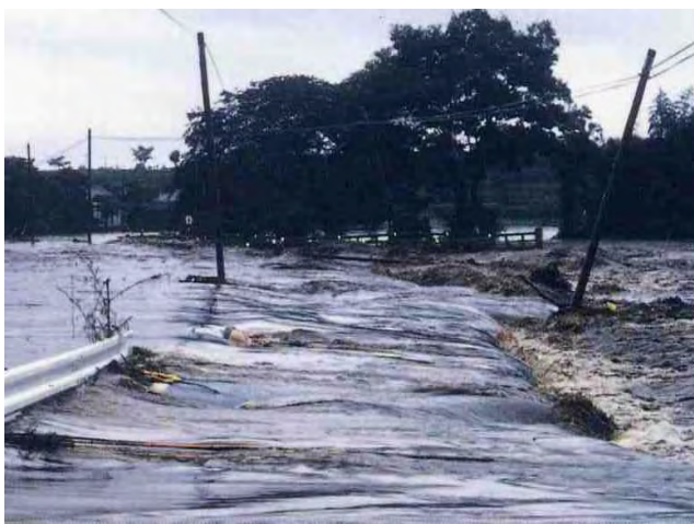
写真 1.2.3 支川合志川 7km 付近の越水による浸水状況 (熊本市)
