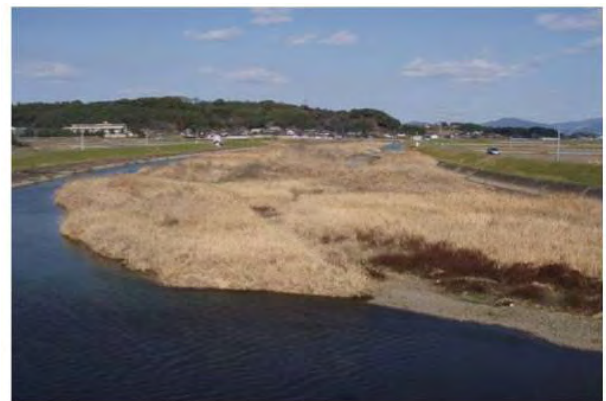
写真 2.1.6 河道内に堆積した土砂（合志川）
