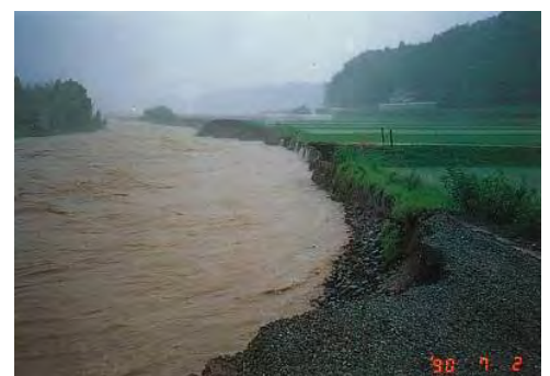
写真 2.1.4 堤防被災状況 （H2.7 上内田川 菊池市）
