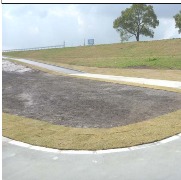
山鹿大堰橋上流付近の様子
