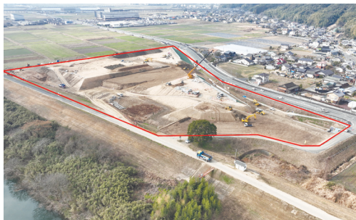
河川防災ステーション整備事業(元玉名地区)
