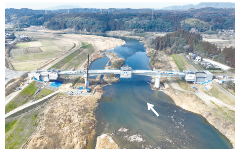
菊池川中流部改修事業(菰田・下津原地区)
