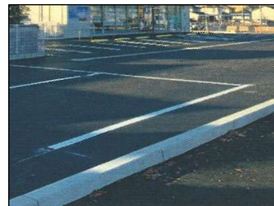
駐車場内の透水性舗装施工例
