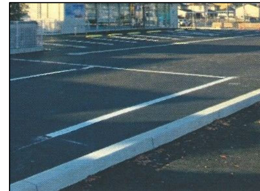
駐車場内の透水性舗装施工例
