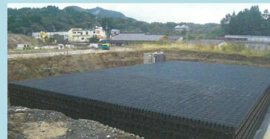
貯留槽設置完了
