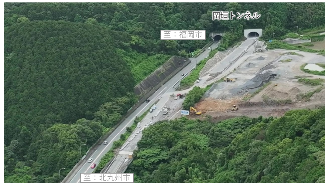
■写真②：岡垣トンネル（北九州市側）の状況
