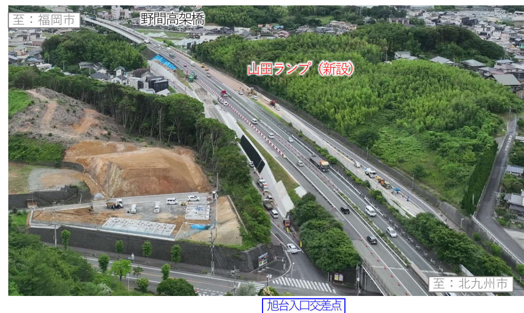
■写真④：山田ランプ（新設）周辺の状況
