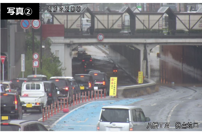
▲ 道路冠水状況 〔国道3号八幡トンネル付近〕 (平成30年7月)
