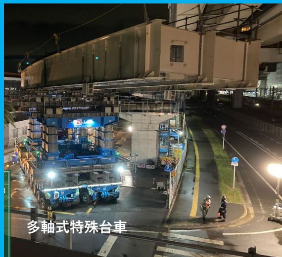
工事のイメージ (多軸式特殊台車による架設状況)
