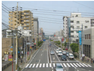
整備前【無電柱化前】
