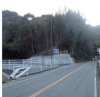
チェーン着脱場整備 （国道201号 飯塚市）
