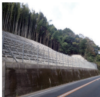
法面对策 （国道201号 飯塚市）
