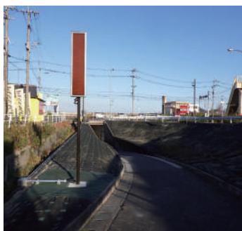
冠水対策（情報板） （国道10号 小倉南区）
