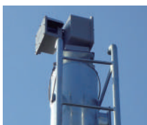
監視(CCTV)カメラ
