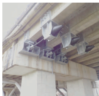
耐震補強（落橋防止装置） （国道201号 東大橋）
