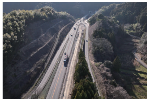
筑穂 IC 付近の施工状況（福岡方面を望む）
