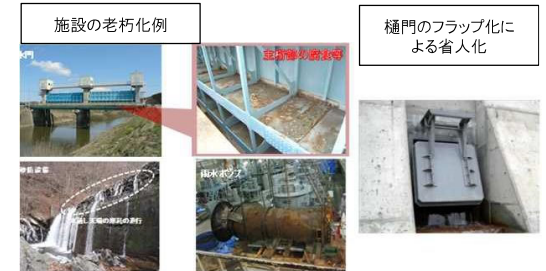
河川管理施設等の老朽化対策
