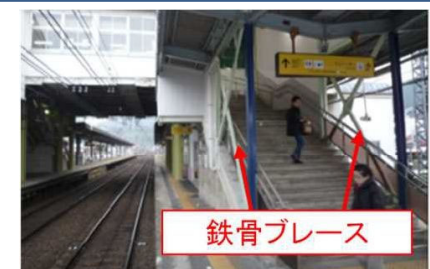
鉄骨ブレース 駅等の耐震補強の対策
