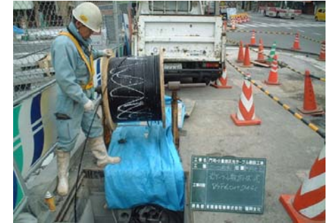
光ケーブル 敷設
