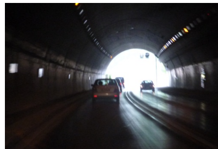
◀ 岡垣トンネル
