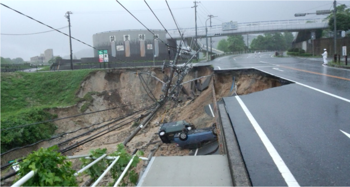
被災状況(7月6日6時)
