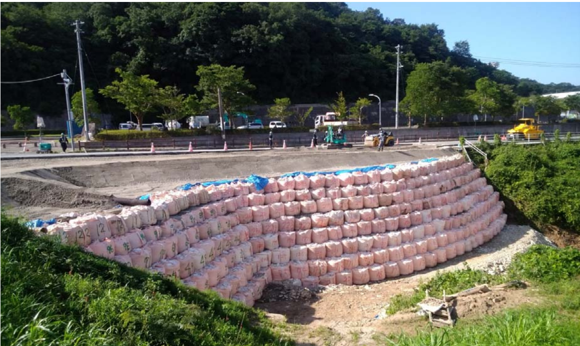
応急復旧工事状況(7月11日9時)
