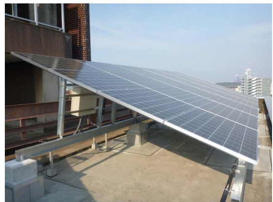
■太陽光発電パネルの設置事例 （大分地方合同庁舎2013年度完成）
