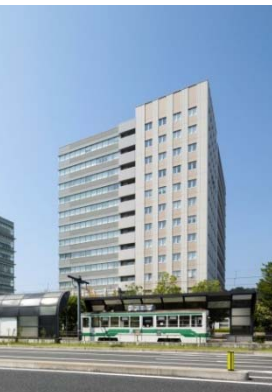
熊本地方合同庁舎A棟 (2010年度完成)
