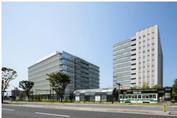
熊本地方合同庁舎B棟 (2014年度完成)
