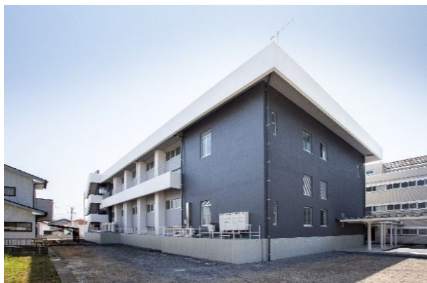
熊本県警察学校（武道場） (2019年度完成)
