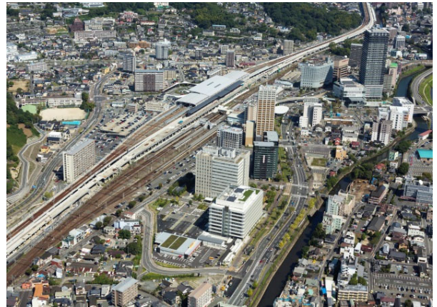
■ 熊本地方合同庁舎（2014年度完成）
