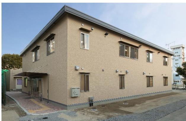
土地改良技術事務所 (2020年度完成)
