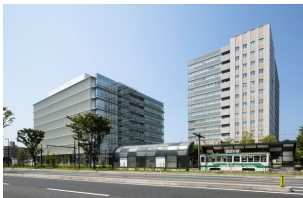
熊本地方合同庁舎B棟 (2014年度完成)
