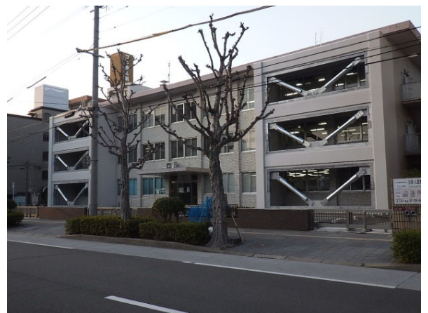
■耐震改修の事例 (九州農政局大分支局2015年度完成)
