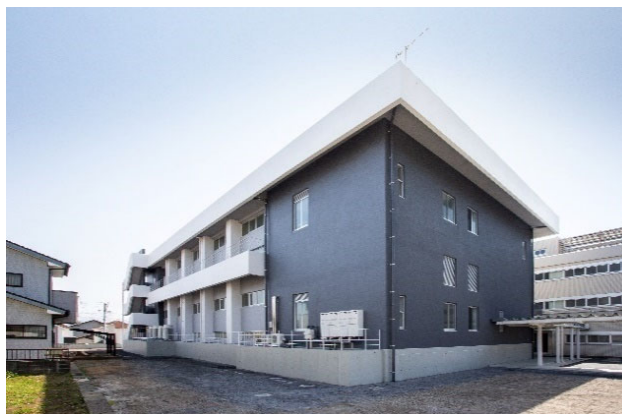
熊本県警察学校（武道場） (2019年度完成)
