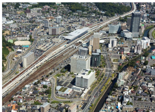
■ 熊本地方合同庁舎（2014年度完成）
