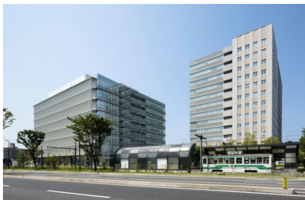
熊本地方合同庁舎B棟 (2014年度完成)
