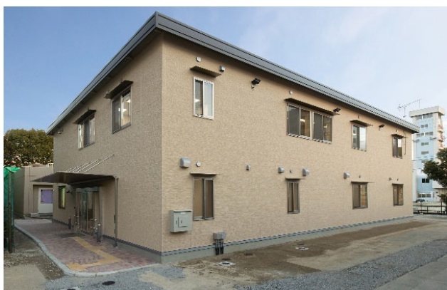
土地改良技術事務所 (2020年度完成)
